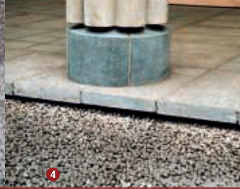
4 Argex uitvullings- en draineerbeton
