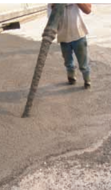
Pompbaar Argexbeton (HST- Merksem)
