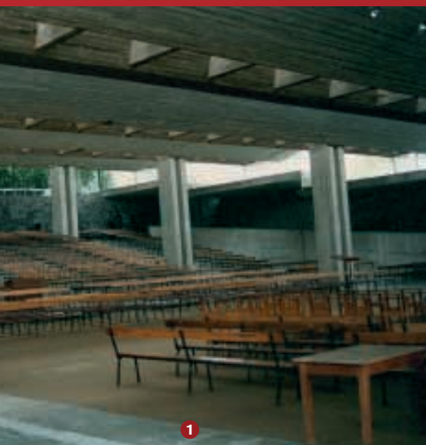
Plafondconstructie in licht structureel beton (Pelgrimsoord - Beauraing)
