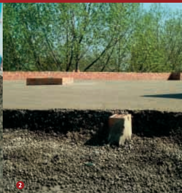
Argex hellingsbeton met afstrijklaag
