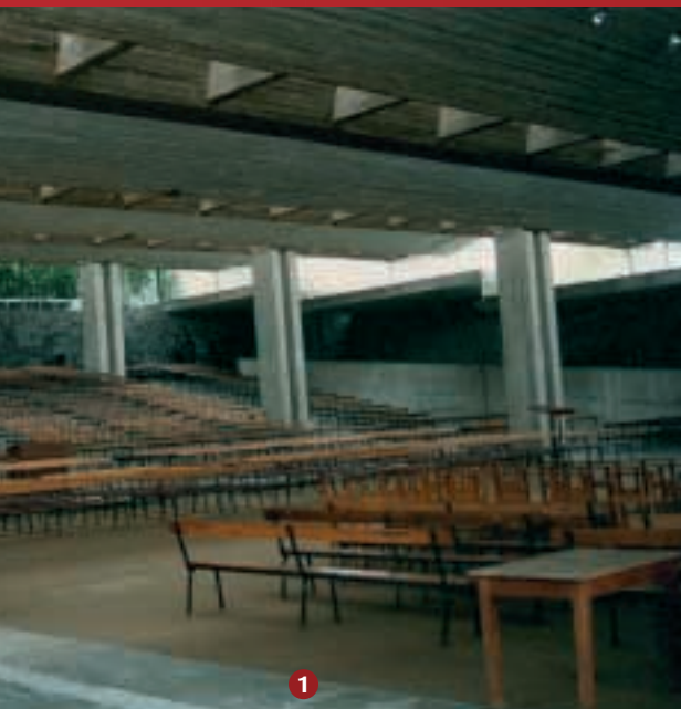
Plafondconstructie in licht structureel beton (Pelgrimsoord - Beauraing)
