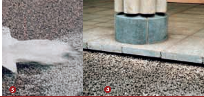
5 Stabiliseren van losse Argexkorrels
