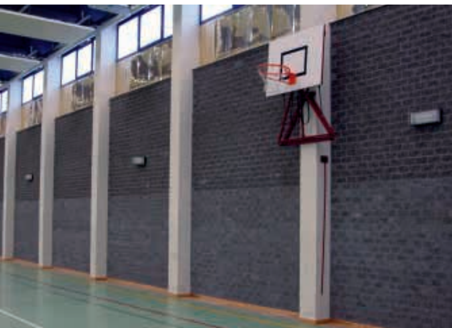
Sporthal in zichtbaar akoestisch metselwerk: combinatie van fijne textuurblokken en splitblokken
