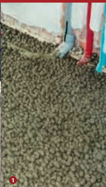
Argex isolerende onderchape
