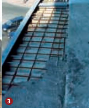
Constructief compactbeton op zwaluwstaartprofielen (Tour Madou - Brussel)
