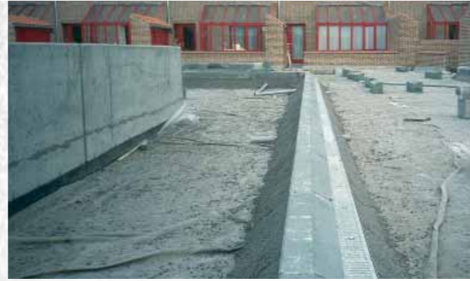
Brugge, Karthuyzerwijk: Boordstenen in draineerbeton
