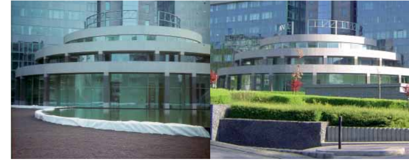
Gent, Gerechtsgebouw L.Bouwens: Argex daktuin op ondergrondse parking (voor en na)
