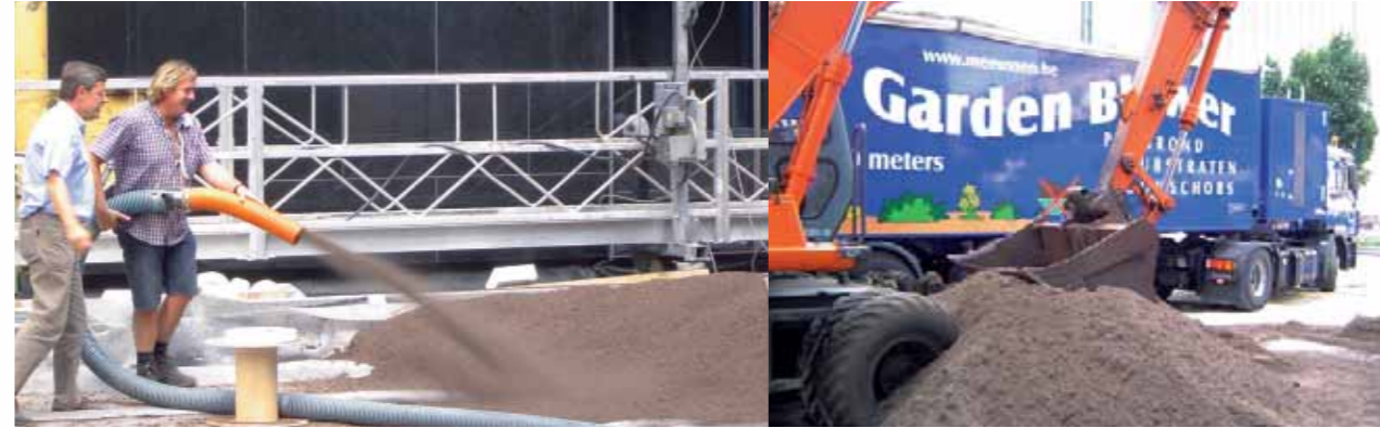
Brussel, Galaxy: Blazen van substraat met Argexkorrels vermengd
