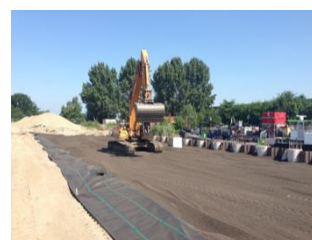
Figure 6: Installation et compactage avec un excavateur
