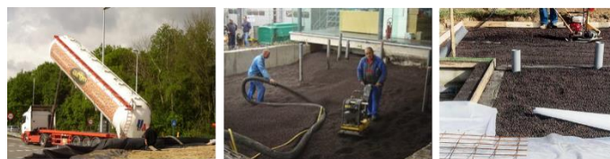
Figure 3: Soufflage par camion silo suivi d'un nivellement et d'un compactage avec une plaque vibrante
