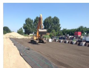
Figure 6: Installation et compactage avec un excavateur
