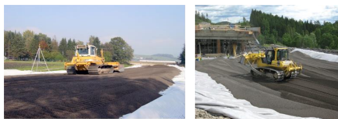
Figure 5: Installation et compactage avec un bulldozer
