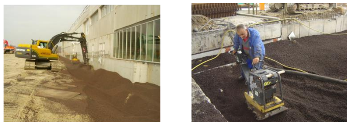
Figure 4: Mise en œuvre par excavateur suivi d'un nivellement et d'un compactage avec une plaque vibrante
