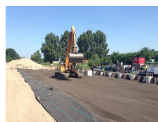
Figure 6: Installation et compactage avec un excavateur
