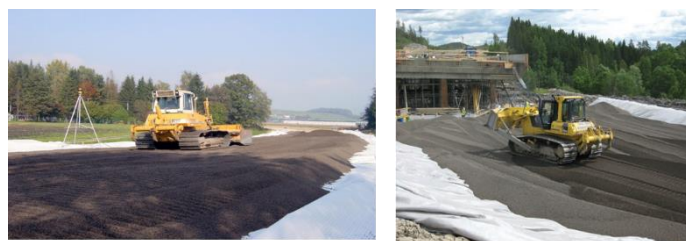
Figure 5: Installation et compactage avec un bulldozer
